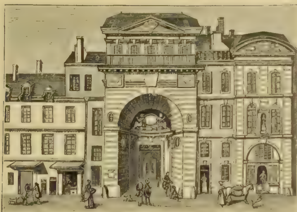
Fig. 154. — Façade du collège d'Harcourt (1675). — D'après l'ouvrage cité p. 345 et 349.
